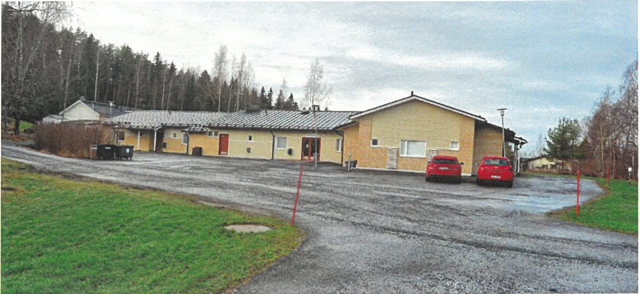
Vesauskoti on rakennettu v. 1992 ja peruskorjattu v. 2015
